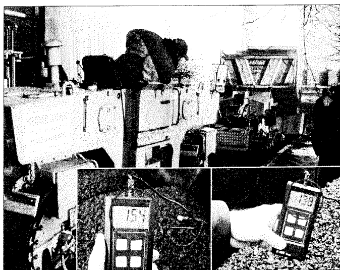
Abb. 3 Asphaltbau, Temperaturkontrolle
