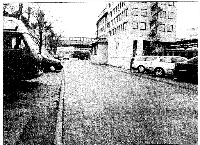
Abb. 1 Versuchsstrecke nach Fertigstellung
