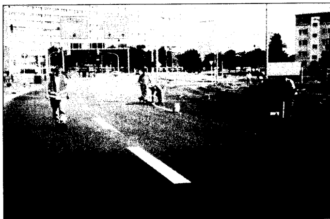
Abb. 4 fertig gestellte Splittmastixasphaltdeckschicht im Jahre 1997
