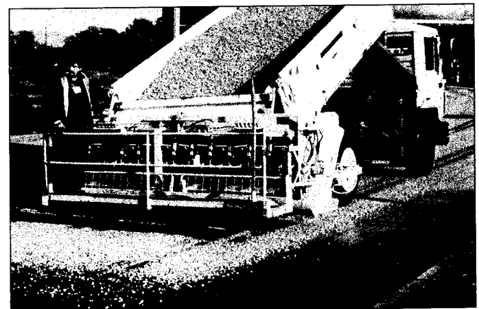
Abb. 3 Herstellen der SAMI-Schicht - Abstreuen mit Splitt 11/16 (10 - 12 kg/m 2 ) (SAMI = Stress Absorbing Membrane Interlayer)
